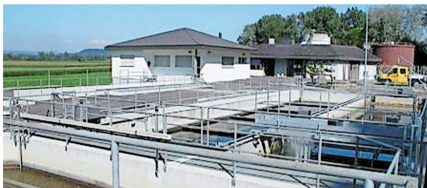
Die Gebühren für das Abwasser in Dorf werden erhöht, unter anderem, um die Mittel für die nötigen Investitionen am Werk vornehmen zu können. Bild: Gemeinde Dorf
